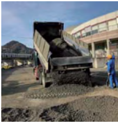
Foto 2 Pie de foto: Descarga y distribución del concreto en sitio Crédito: Mapei SpA
