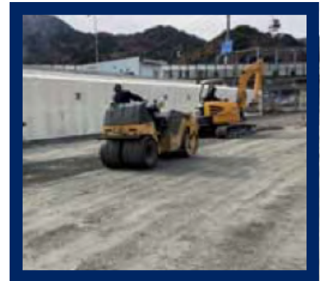
Foto 3 Pie de foto: Compactación del CCR utilizando cilindros vibratorios Crédito: Mapei SpA
