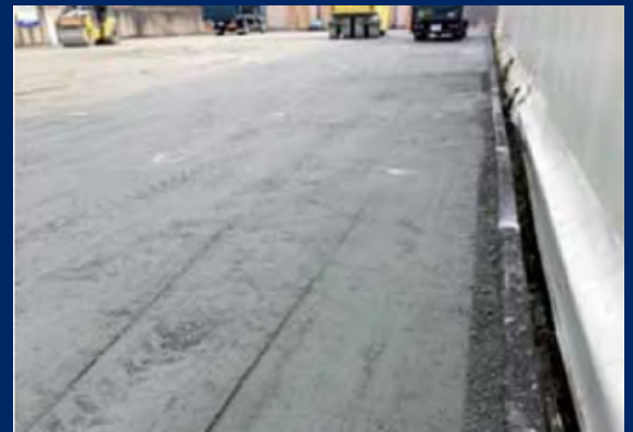
Foto 4 Pie de foto: Un primer plano del CCR durante la fase de compactación con cilindros vibratorios. Los agregados reciclados se compactan perfectamente y están unidos sólidamente en la matriz cementosa. Crédito: Mapei SpA
